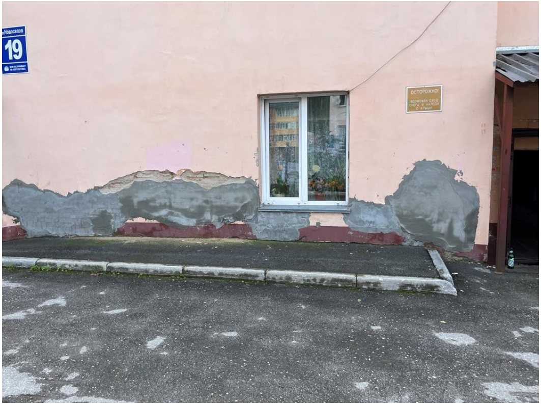
Фото 47. Фасад по оси Л/9-11
