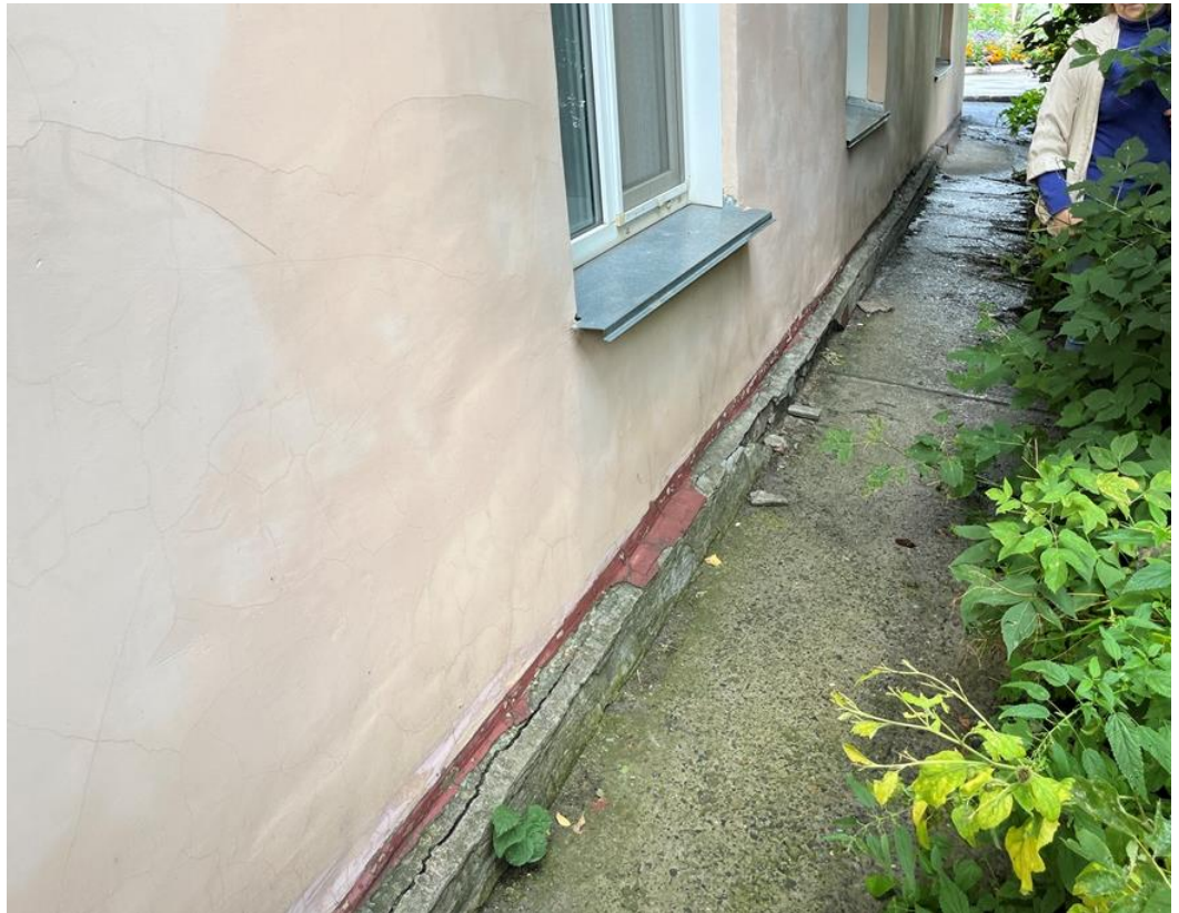
Фото 48. Фасад по оси 11
