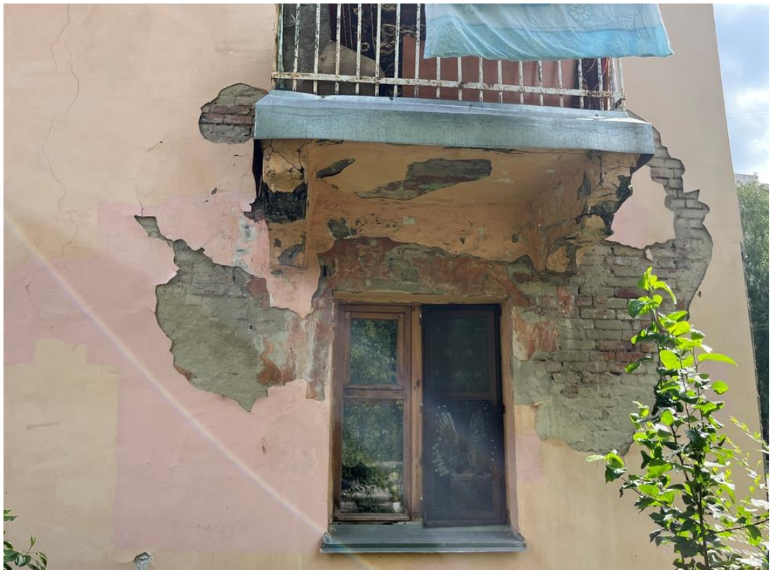
Фото 56. Фасад по оси 1
