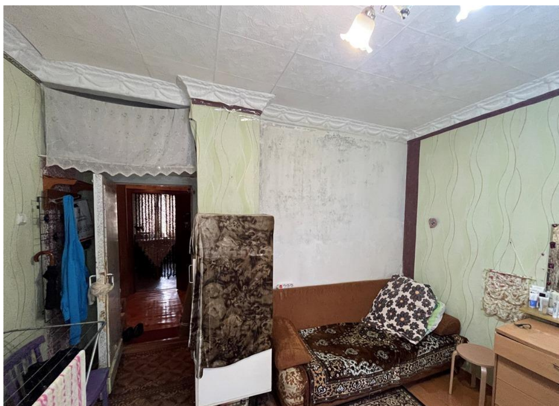
Фото 28. Замачивание перегородки по оси Д/5-6 1 этаж
