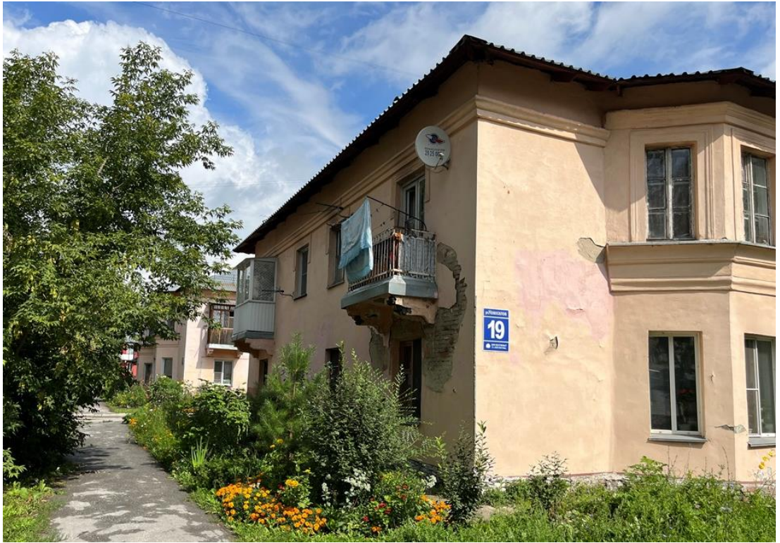
Фото 55. Фасад по оси 1
