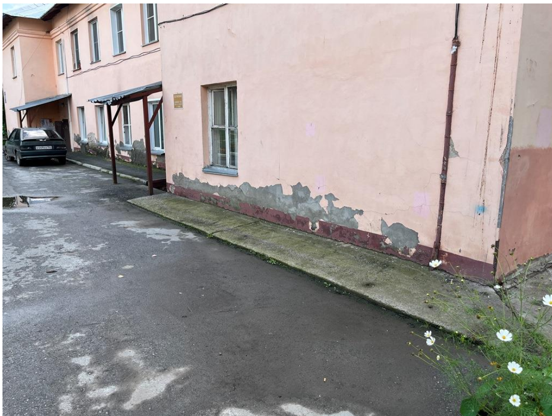
Фото 57. Фасад по оси Л/1-3
