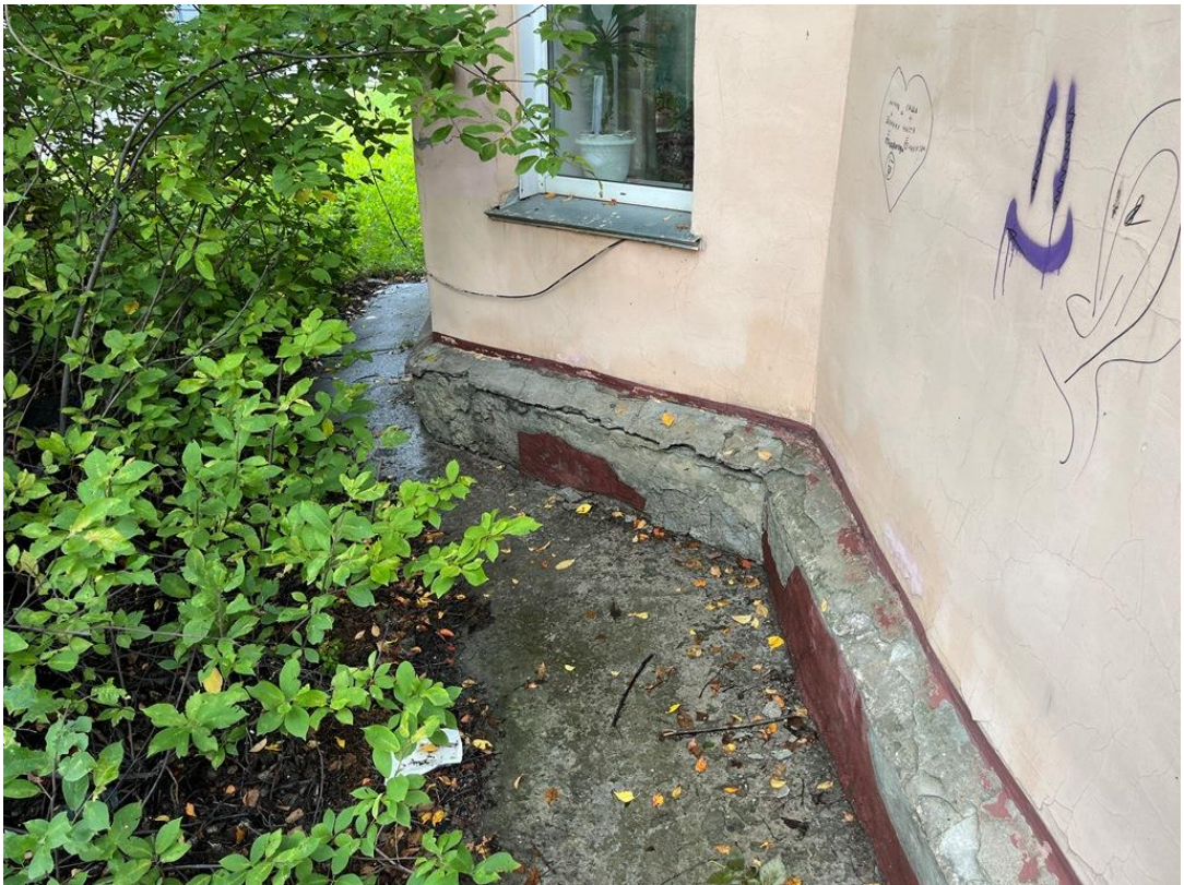
Фото 50. Фасад по оси А/9-11
