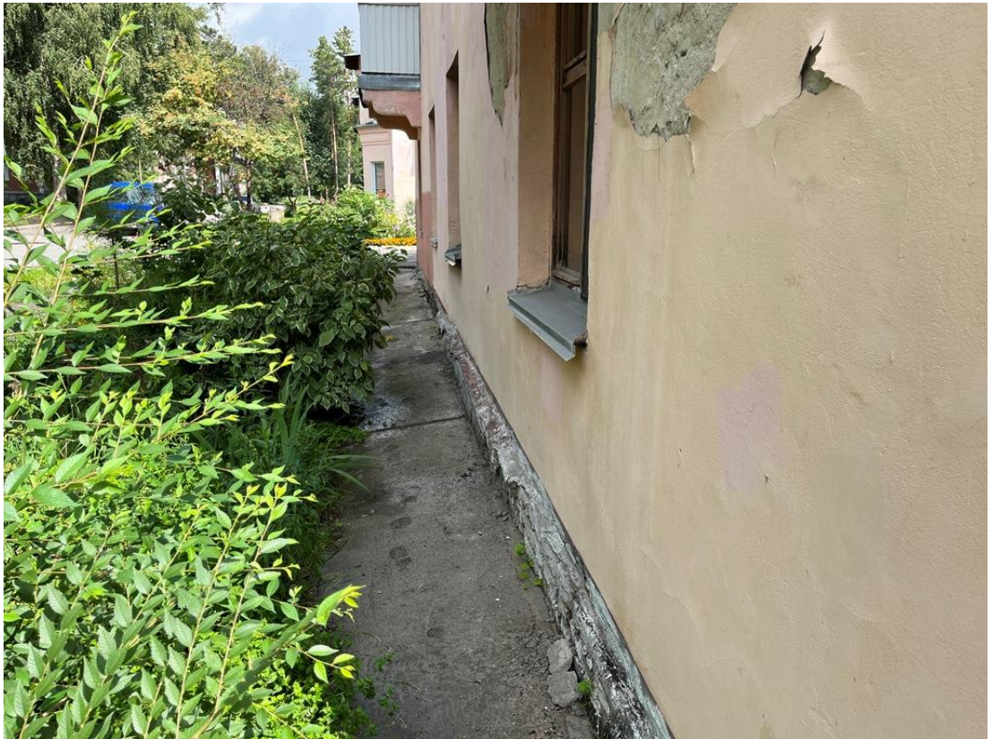
Фото 54. Фасад по оси 1
