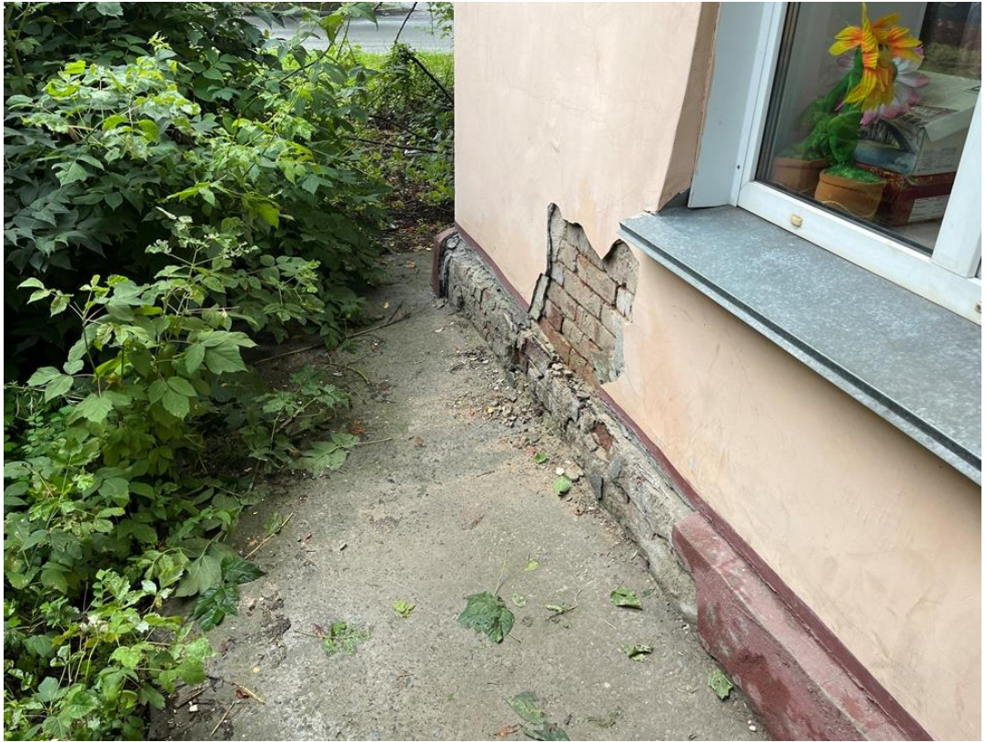
Фото 49. Фасад по оси 11
