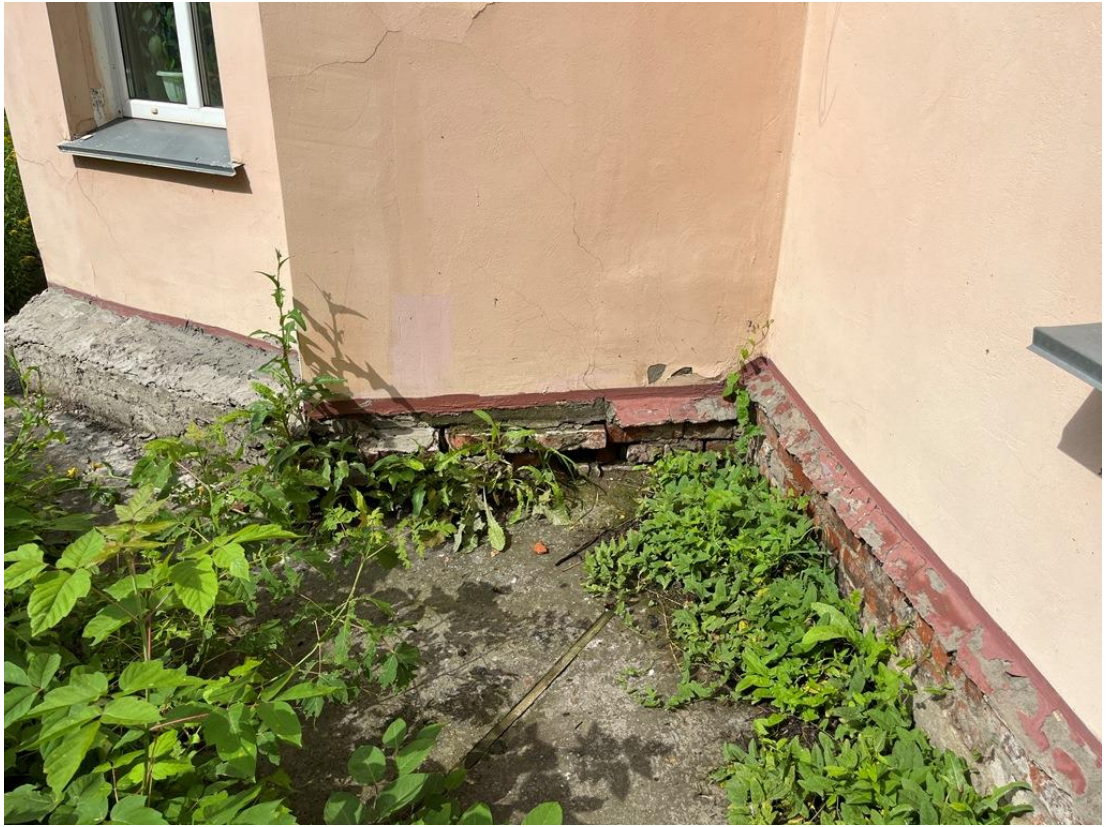
Фото 53. Фасад по оси А/2-3
