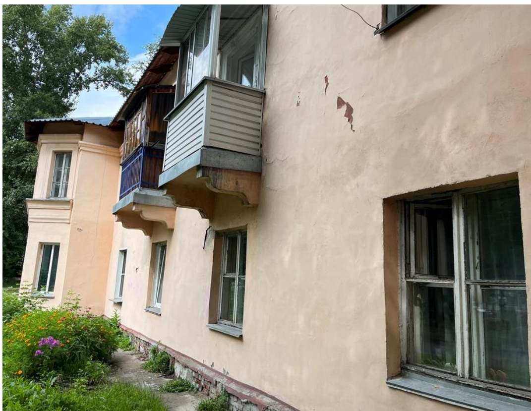
Фото 52. Фасад по оси В
