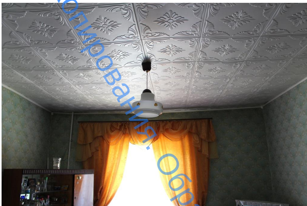
Фото 30. Перекрытие А-Б/5-7 (кв. 7)
