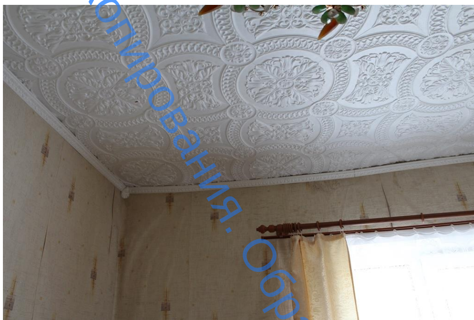
Фото 36. Перекрытие А-Б/5-7 (кв. 5)
