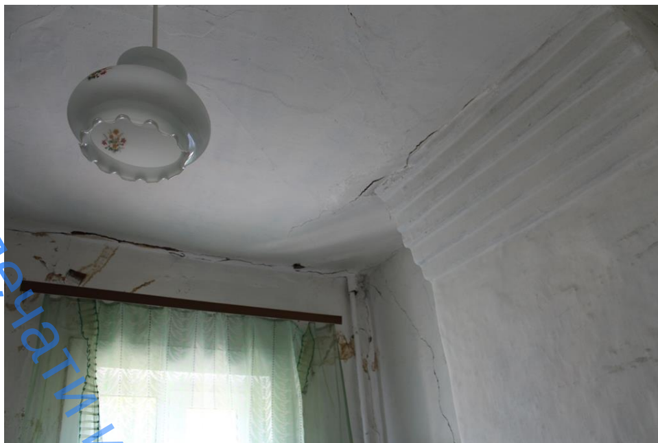
Фото 29. Перекрытие Б-Г/5-6 (кв. 7)
