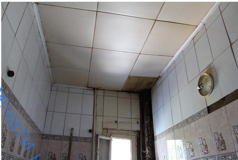
Фото 35. Перекрытие Б-Г/10-11 (кв. 1)
