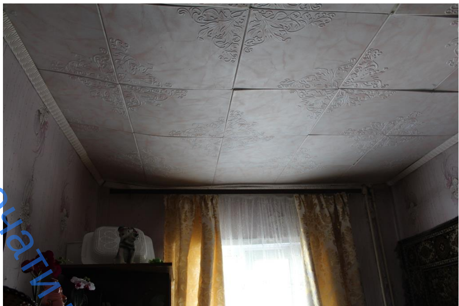
Фото 31. Перекрытие Б-Г/12-13 (кв. 1)
