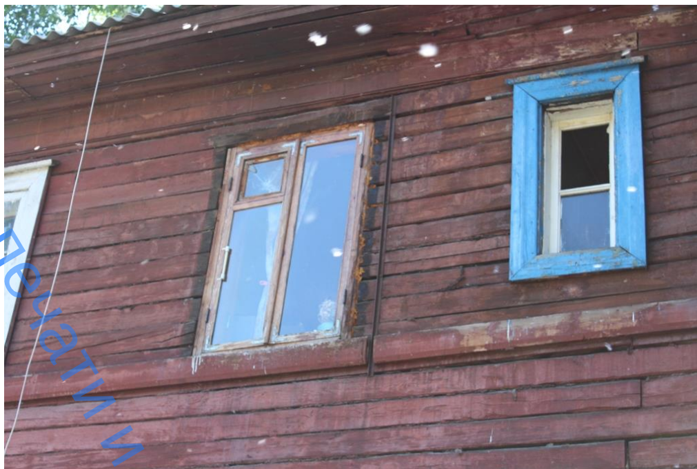
Фото 19. Фасад ось Г. Усиление
