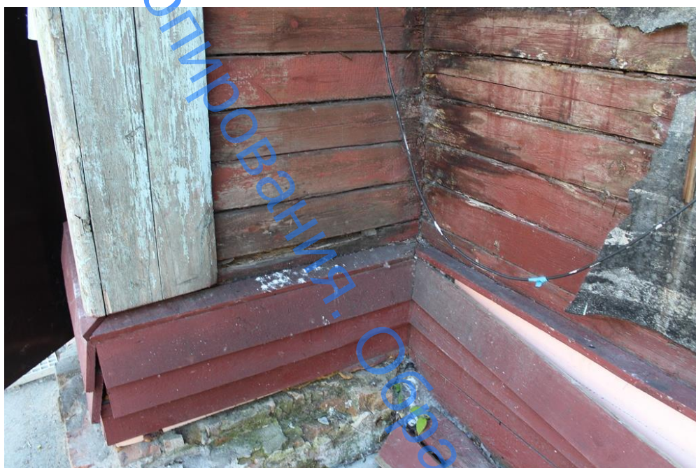
Фото 18. Фасад ось У
