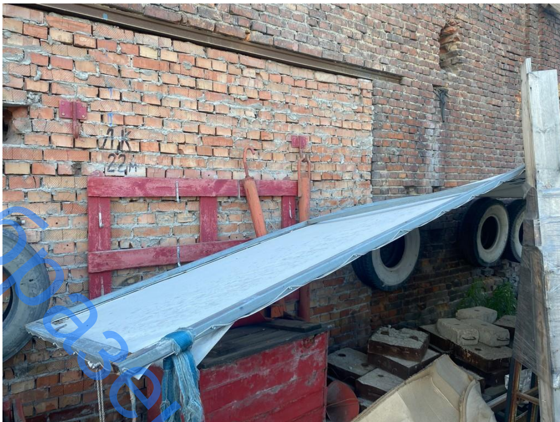
Фото 29 – Замена участка кирпичной кладки
