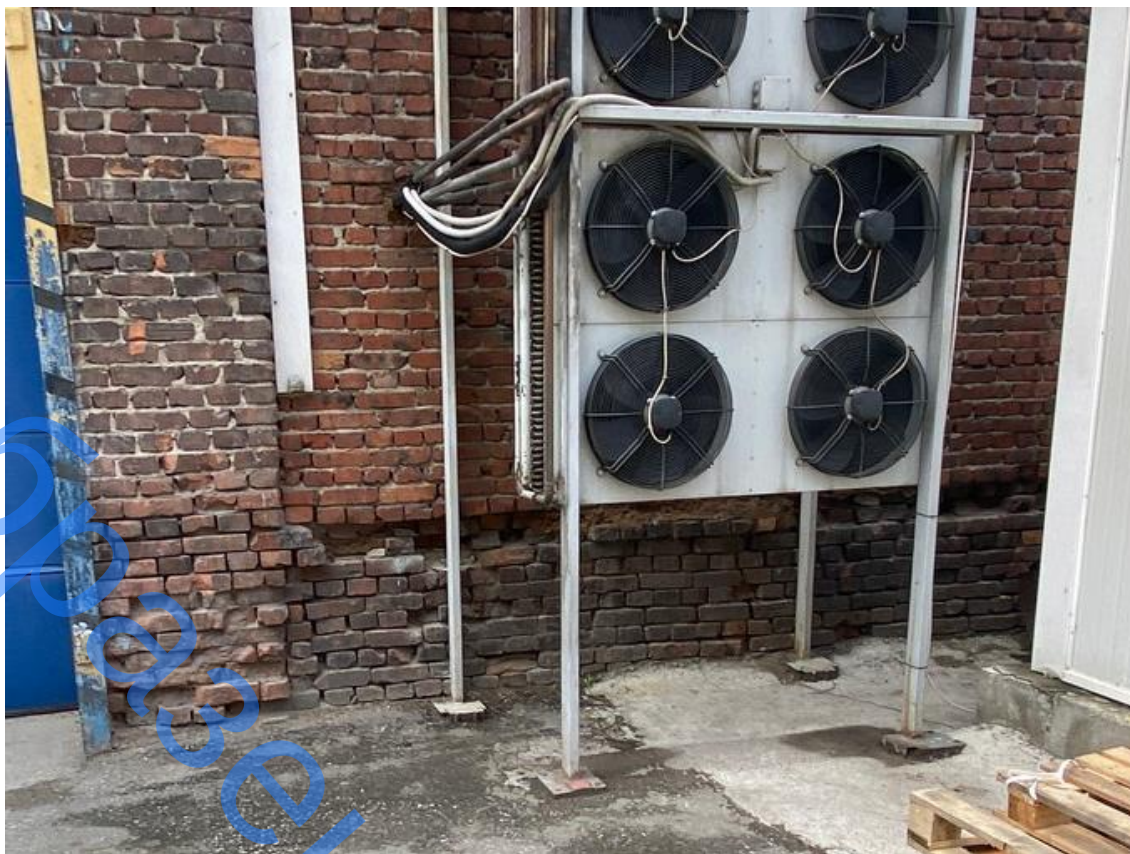
Фото 33 – Вывалы кирпичной кладки, выветривание раствора кирпичной кладки
