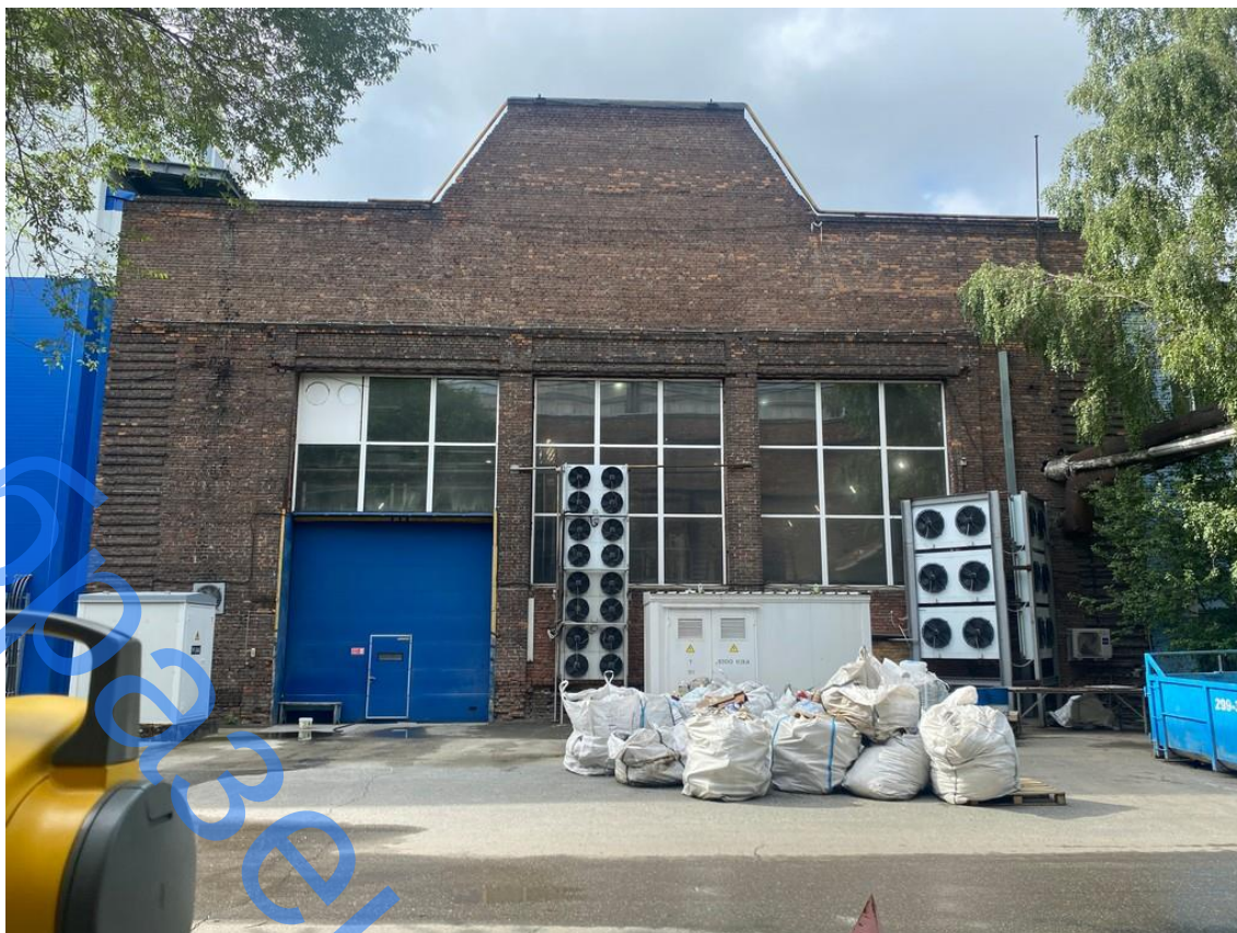
Фото 3 – Общий вид фасада здания в осях 2-1
