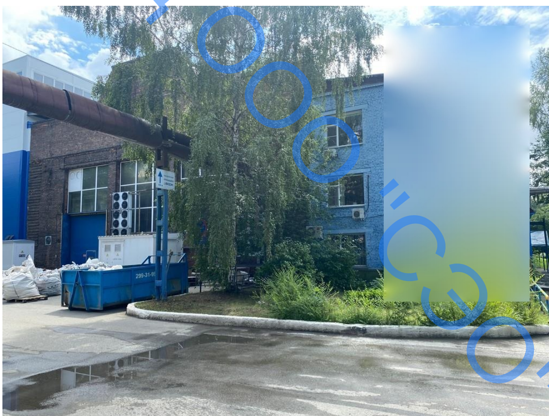
Фото 4 – Общий вид фасада здания в осях Б*-А*
