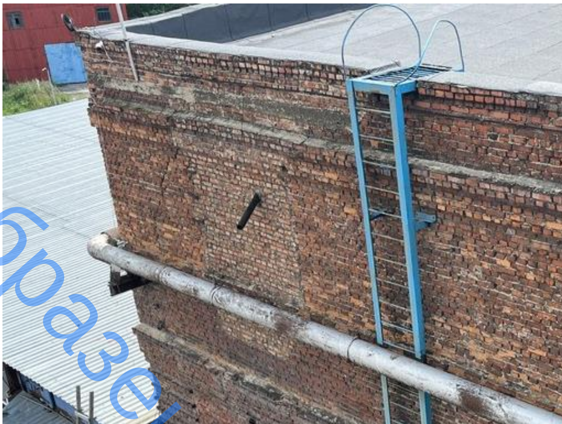
Фото 23 – Замена участка кирпичной кладки
