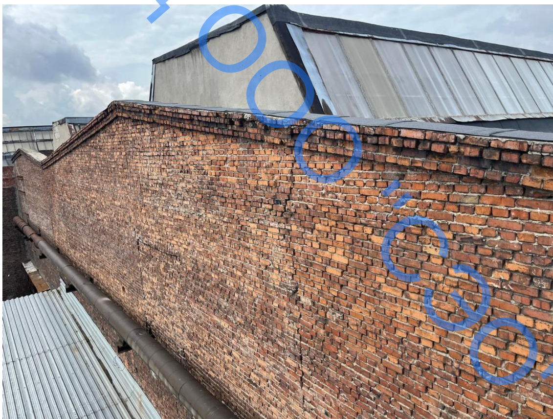
Фото 2 – Общий вид фасада здания в осях Б-А
