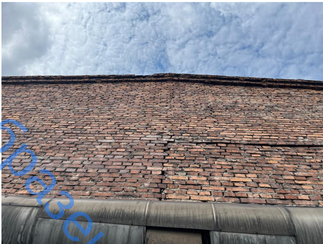
Фото 13 – Сквозная трещина
