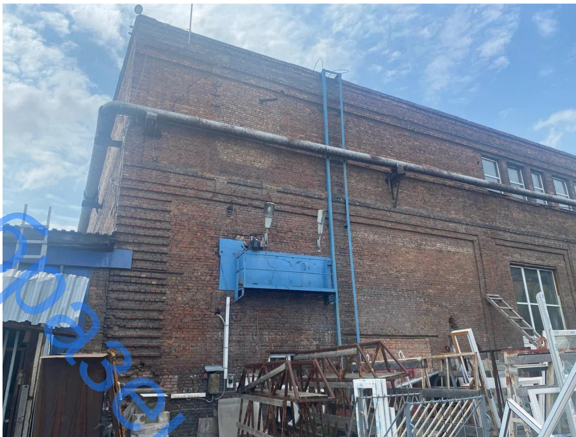
Фото 1 – Общий вид фасада здания в осях 20-18
