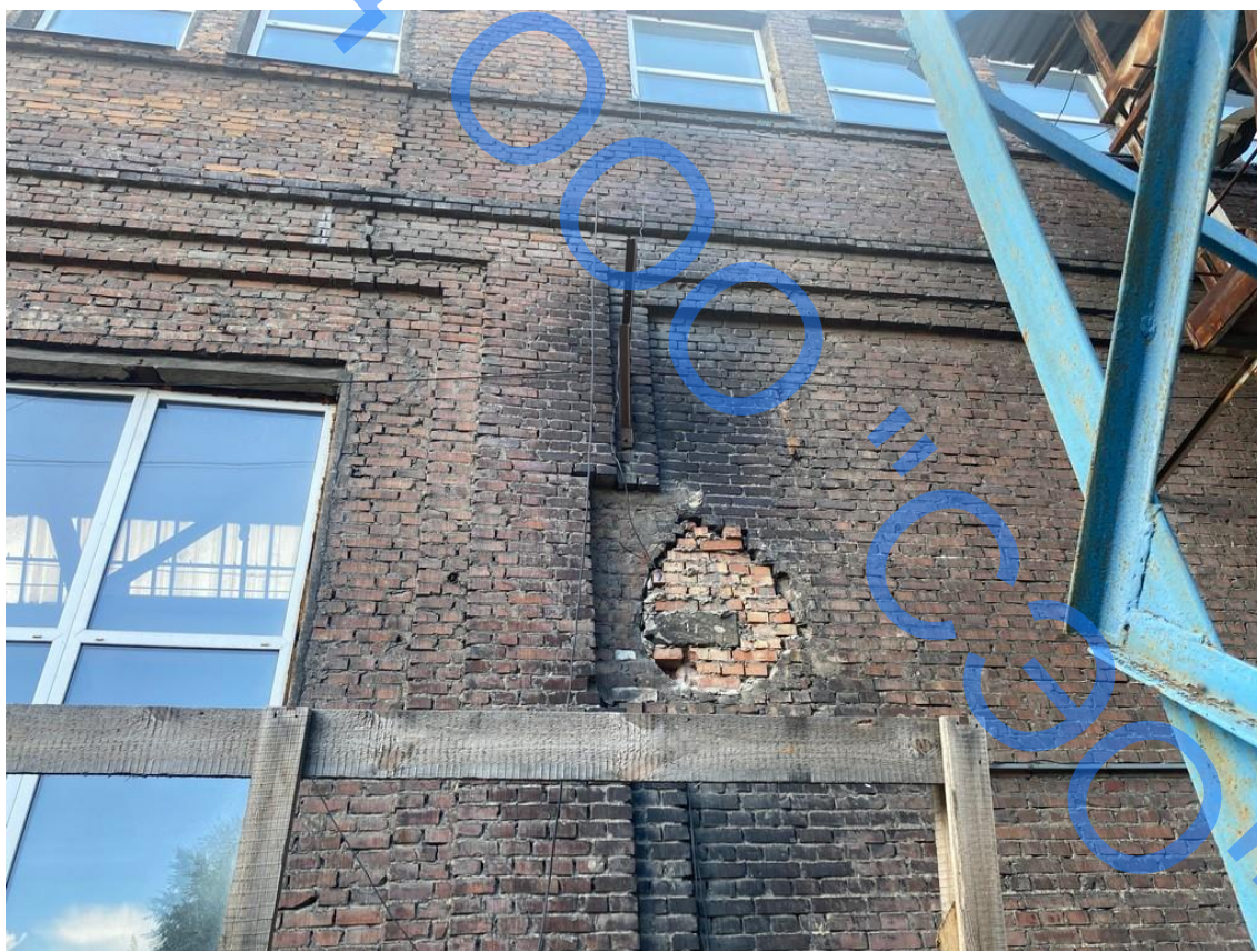
Фото 24 – Замена кирпичной кладки, сквозная трещина по стене
