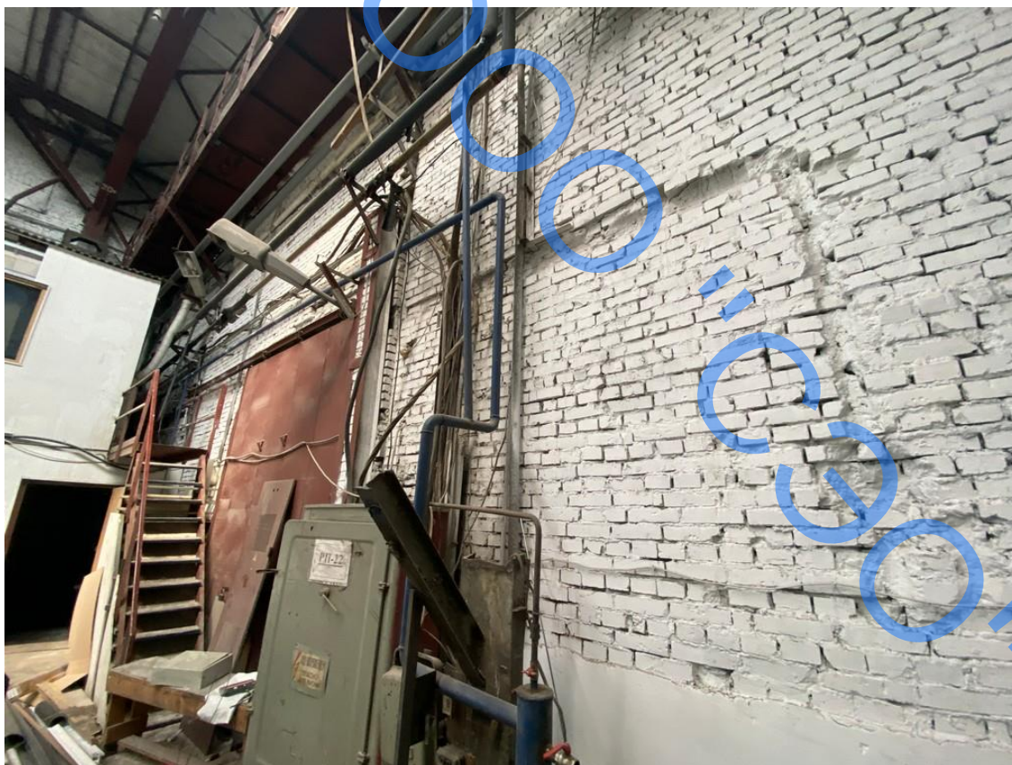
Фото 46 – Замена участка кирпичной кладки
