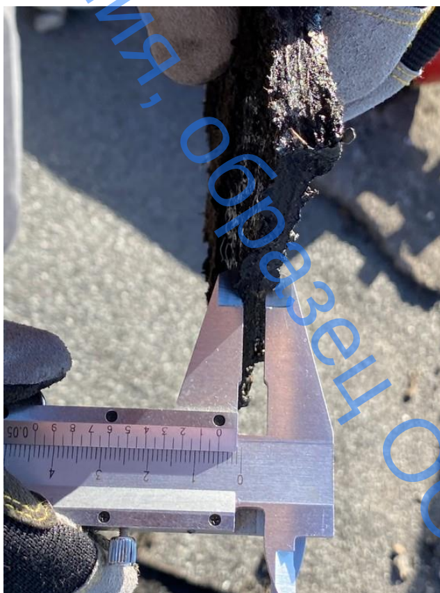
Фото 42 – Вскрытие кровли №1 (толщина 1-го слоя гидроизоляции 5 мм)
