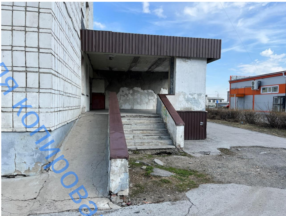
Фото 11 – Общий вид запасного выхода по оси 1
