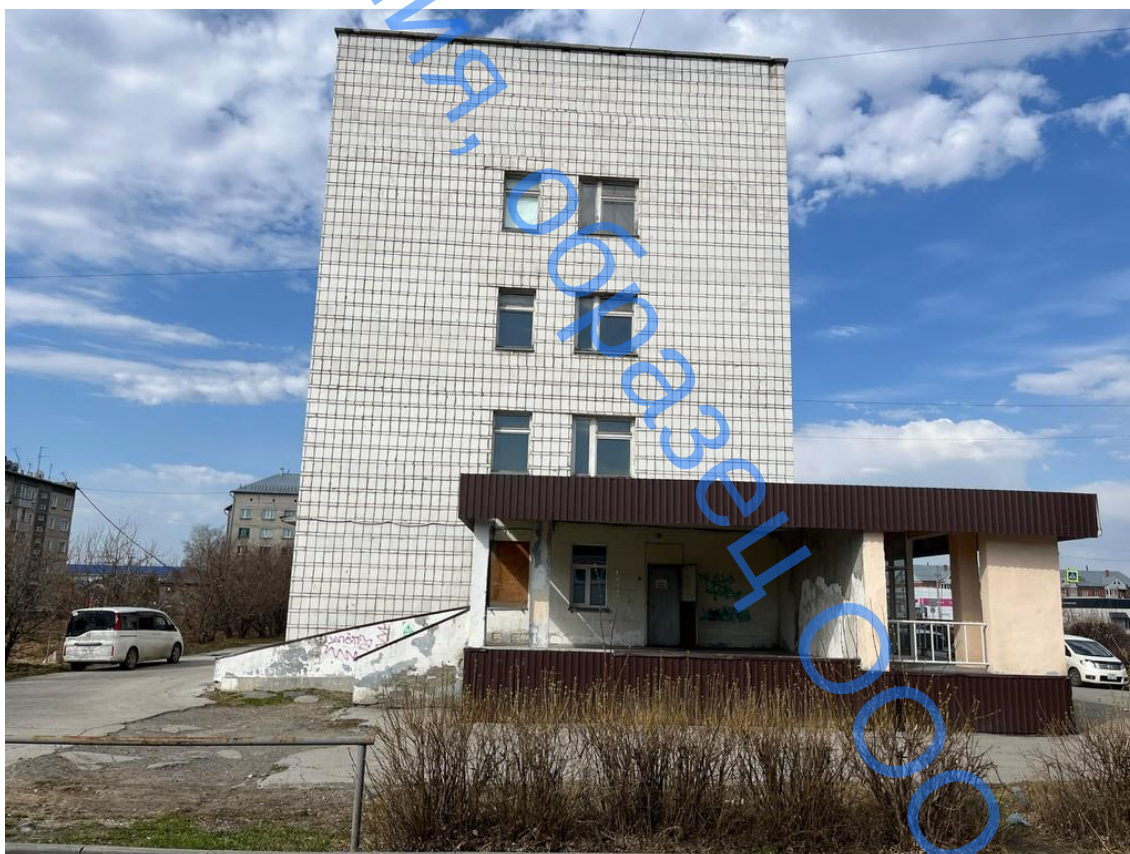
Фото 4 – Общий вид фасада здания по оси 1
