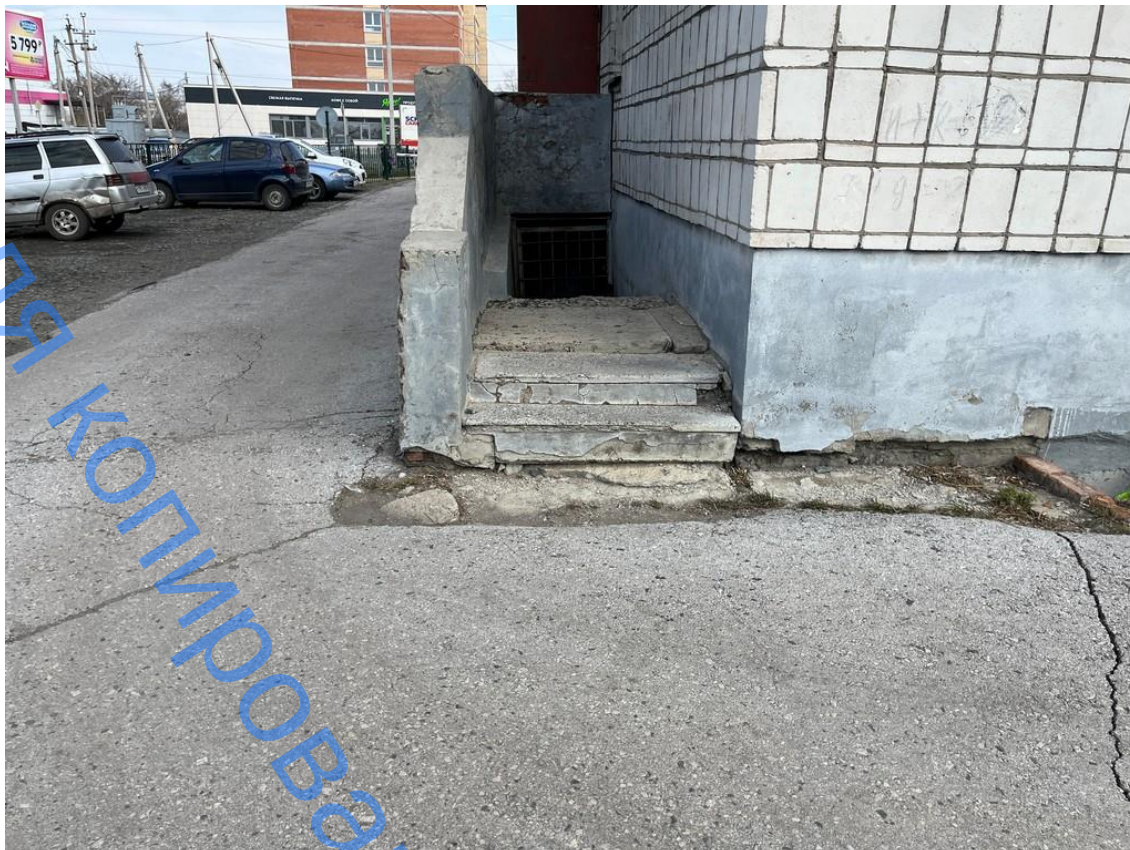
Фото 5 – Общий вид спуска в подвал по оси 2
