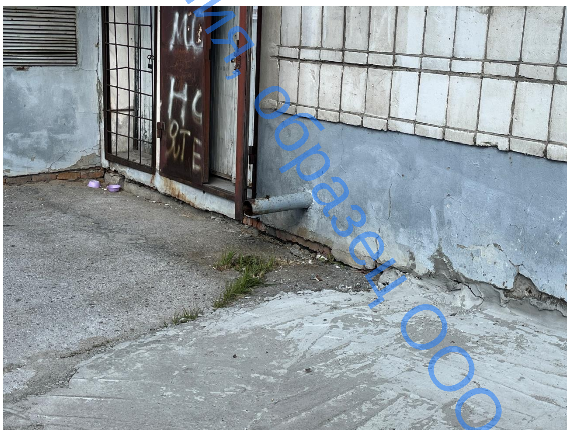
Фото 10 – Общий вид выпуска ливневой канализации
