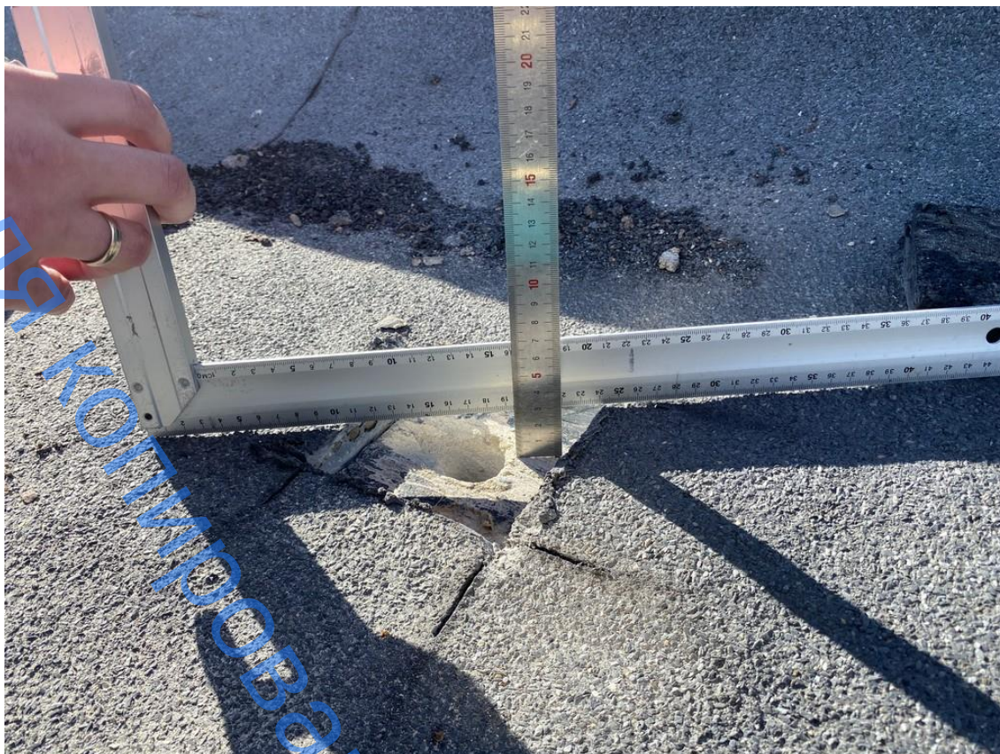
Фото 41 – Вскрытие кровли №1 (общая толщина гидроизоляции 30 мм)
