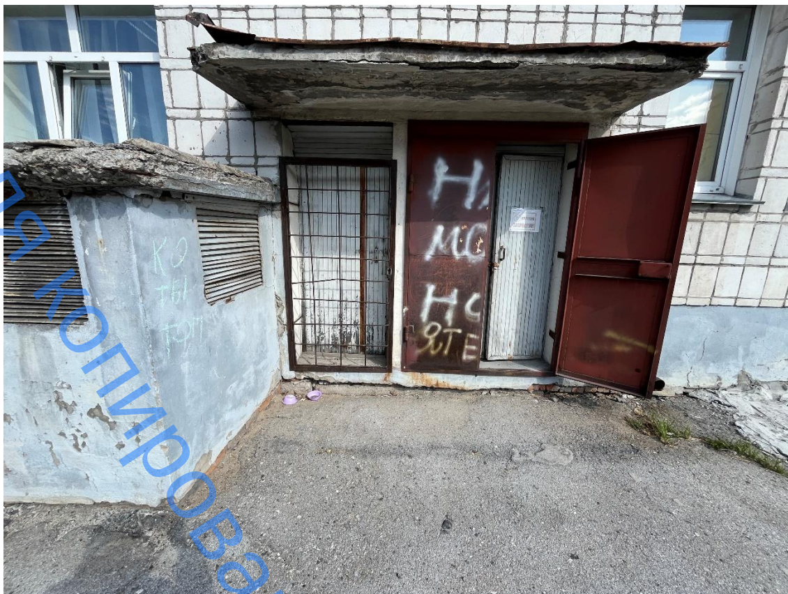
Фото 9 – Общий вид запасного выхода по оси В
