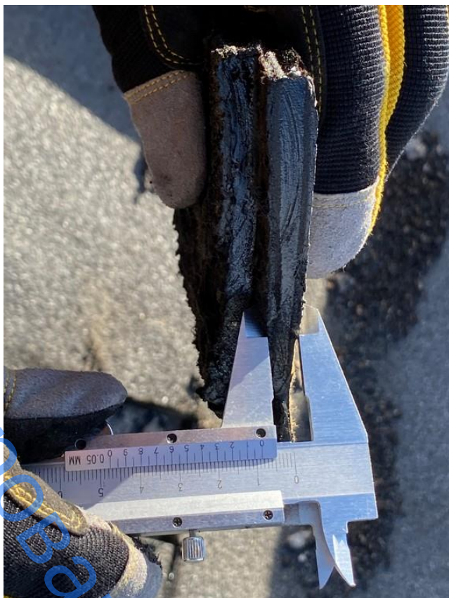
Фото 43 – Вскрытие кровли №1 (толщина 2-го слоя гидроизоляции 8,5 мм)
