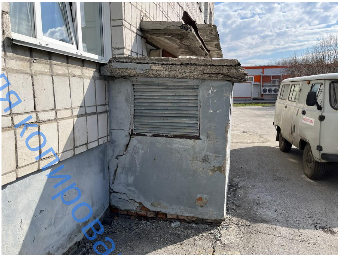
Фото 7 – Общий вид вентиляционной шахты приточной системы вентиляции
