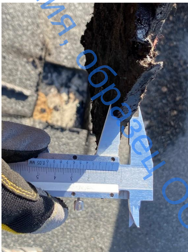
Фото 44 – Вскрытие кровли №1 (толщина 3-го слоя гидроизоляции 6 мм)
