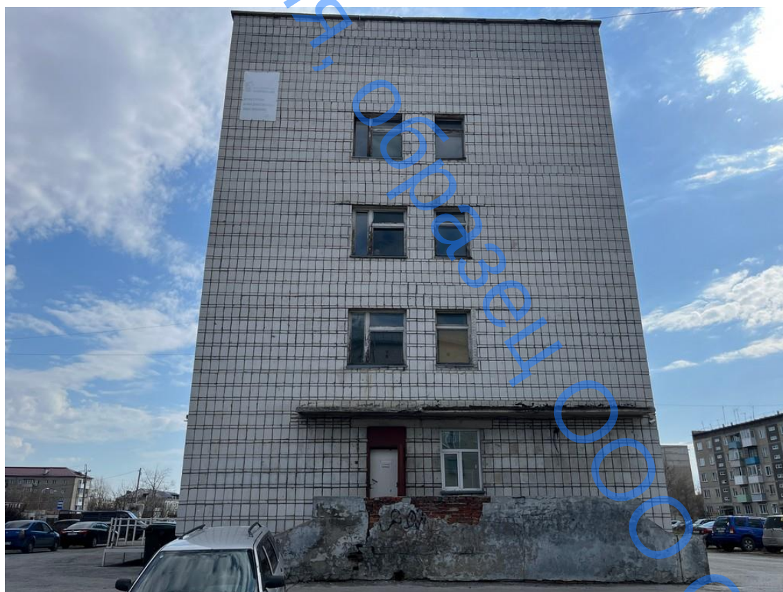
Фото 2 – Общий вид фасада здания по оси 2
