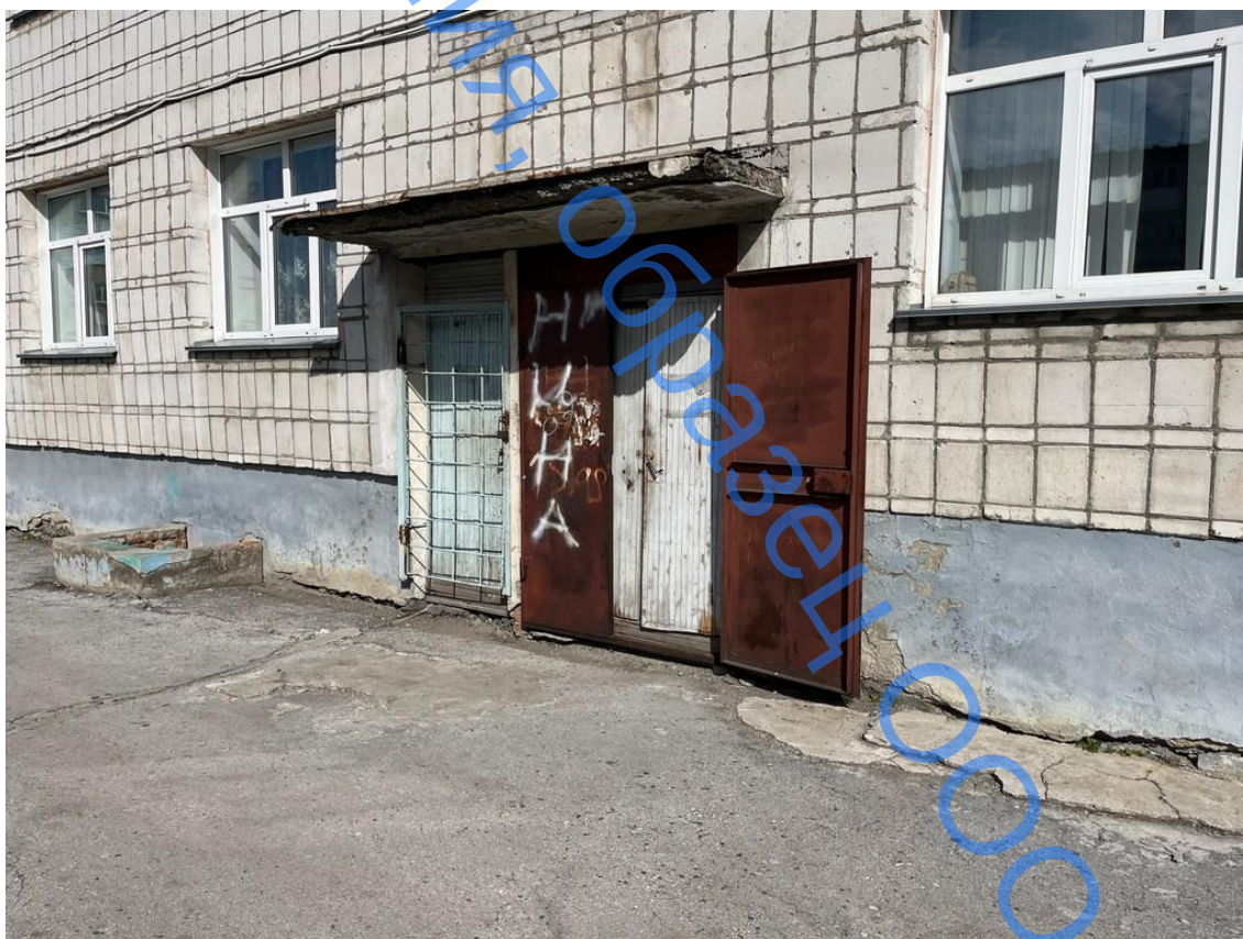
Фото 6 – Общий вид запасного выхода по оси В
