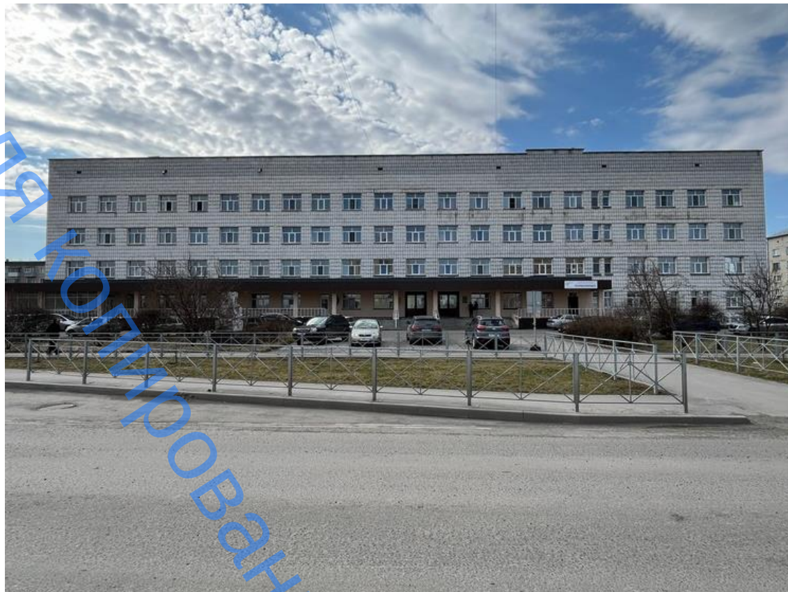
Фото 1 – Общий вид фасада здания по оси А
