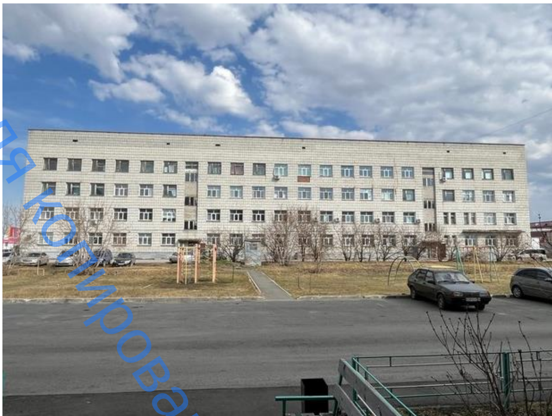
Фото 3 – Общий вид фасада здания по оси В
