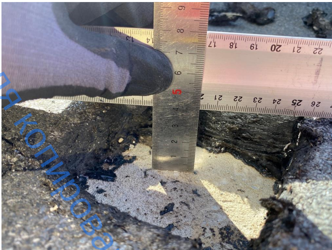
Фото 45 – Вскрытие кровли №2 (общая толщина гидроизоляции 41 мм)
